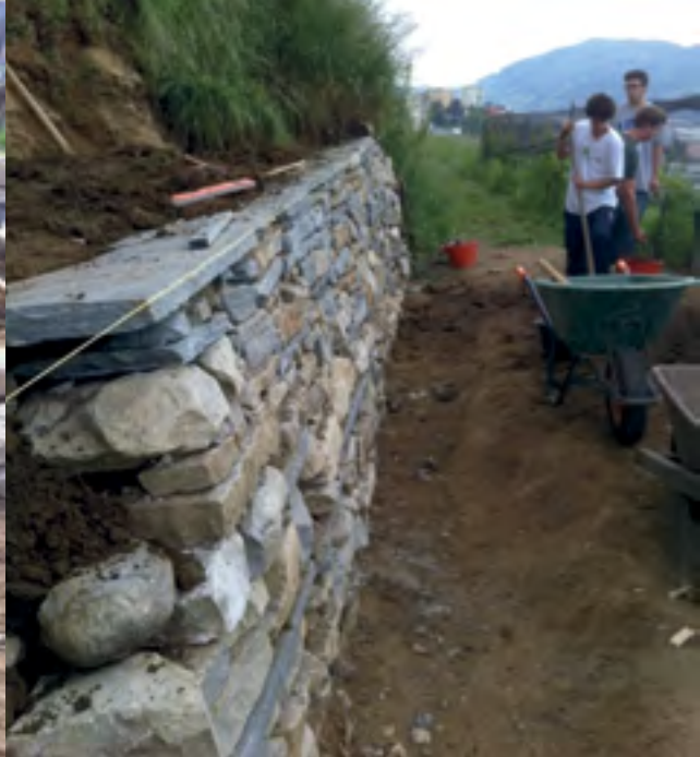
Lavori di preparazione per la base del muro Costruzione di un muro a secco (Foto N. Petrini)
