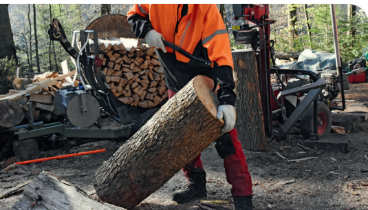
Con le sappe, il materiale spaccato può essere spostato più delicatamente.
