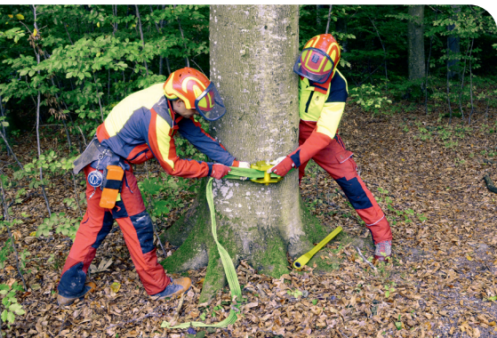
L'utilisation d'un serre-tronc empêche le tronc de se fendre. (Photo: Bundesforschungszentrum für Wald (BFW)/Lackner)
